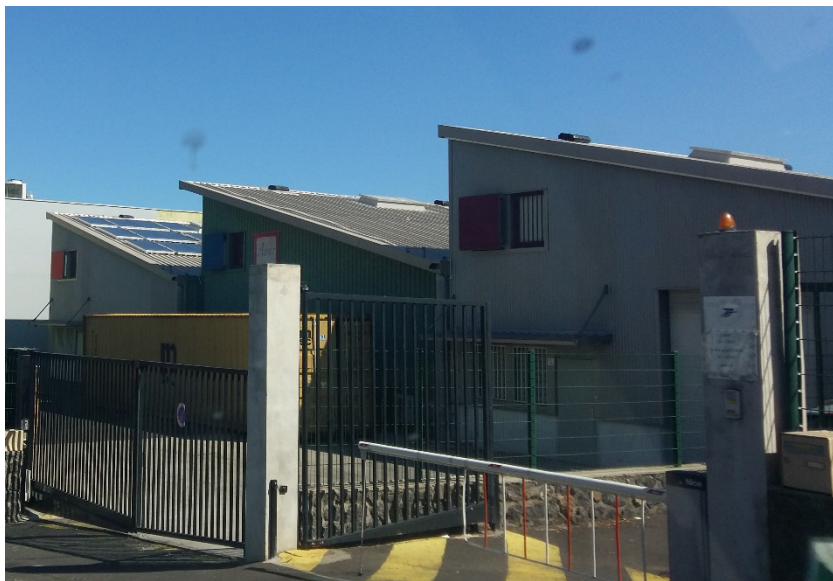
Figure 1 : Vue du bâtiment étudié et des capteurs solaires installés en toiture
