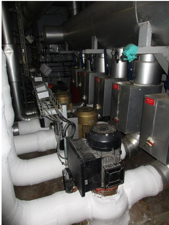
Figure 15 : Pompes de distribution d'eau glacée (KSB Etaline avec variateur de fréquence intégré).
