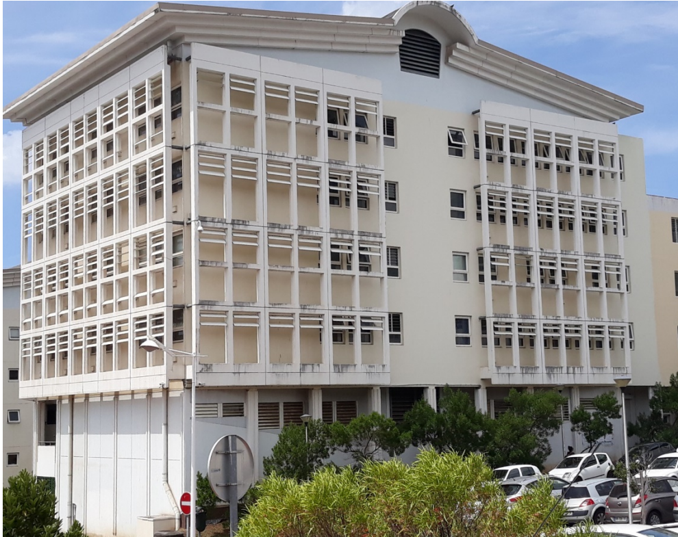
Figure 4 : Vue du bâtiment de la Fac de lettres
