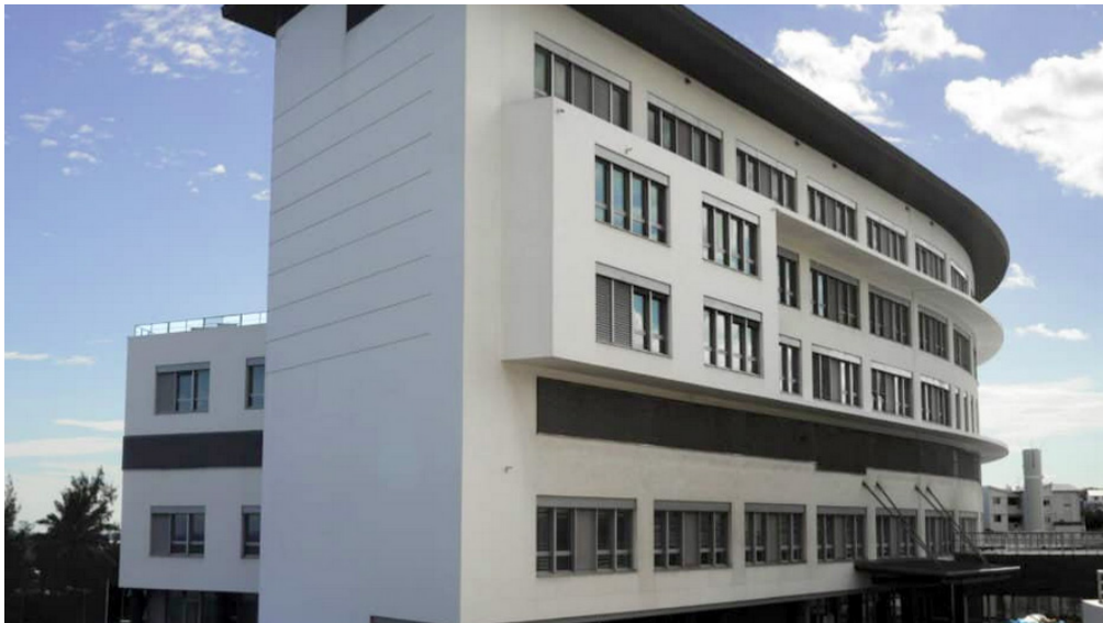
Figure 4 : Vue du bâtiment du PFME (source : CHU)
